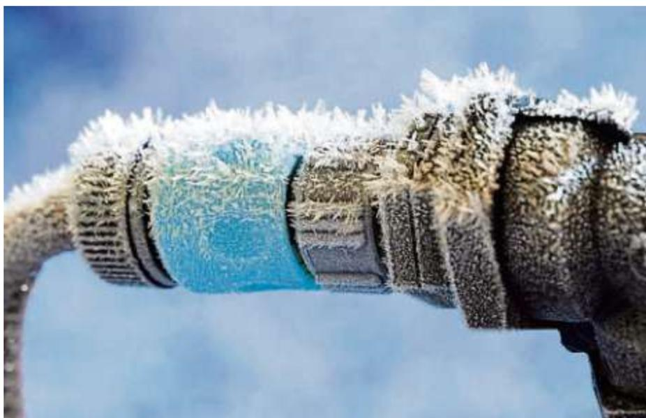
**Frostgefährdete Wasserleitungen wie etwa die Ventile der Außenanschlüsse sollte man im Winter vorsichtshalber sperren und entleeren, raten die Kommunalbetriebe.**
